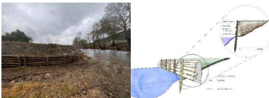
Figura 24 – Paliçada viva (fotografia, secção transversal e alçado)
