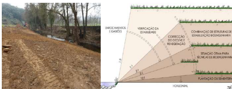
Figura 21 – Reperfilamento dos taludes marginais (fotografia e esquema)
