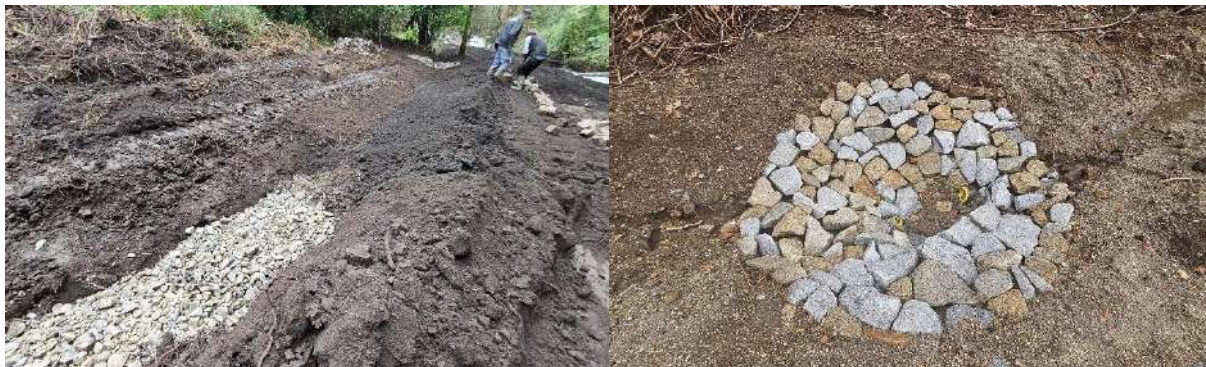
Figura 32 – Exemplo de sistema de biovaletas e respetivos pontos de descarga
